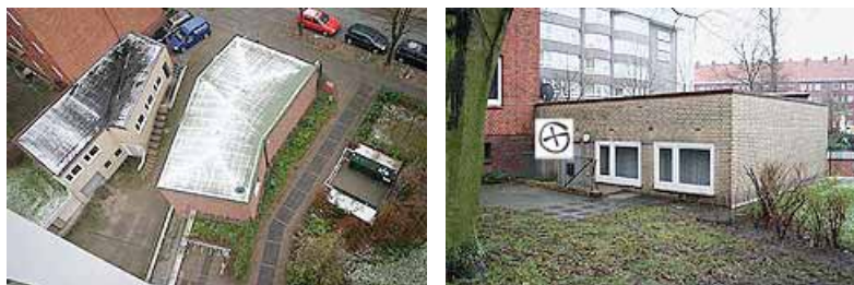
Das ausrangierte Waschhaus in Hamburg-Hamm, Foto: um
